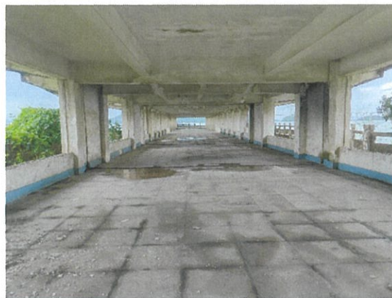
联检大楼室内状况
